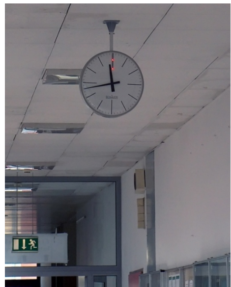
Bildtext: Uhr mit optischem Stellmodul – eine sogenannte „Rot-Licht-Uhr“
